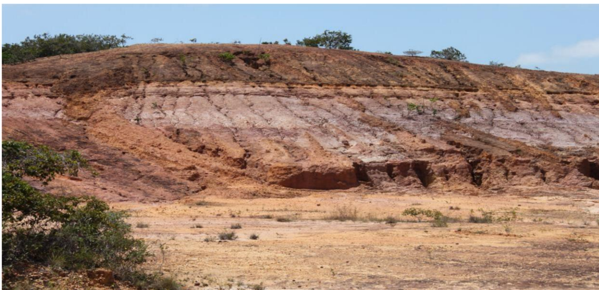
Figura 116 – Processos Erosivos nas encostas dos Tabuleiros Costeiros em Itaporanga D’Ajuda, 2013.
