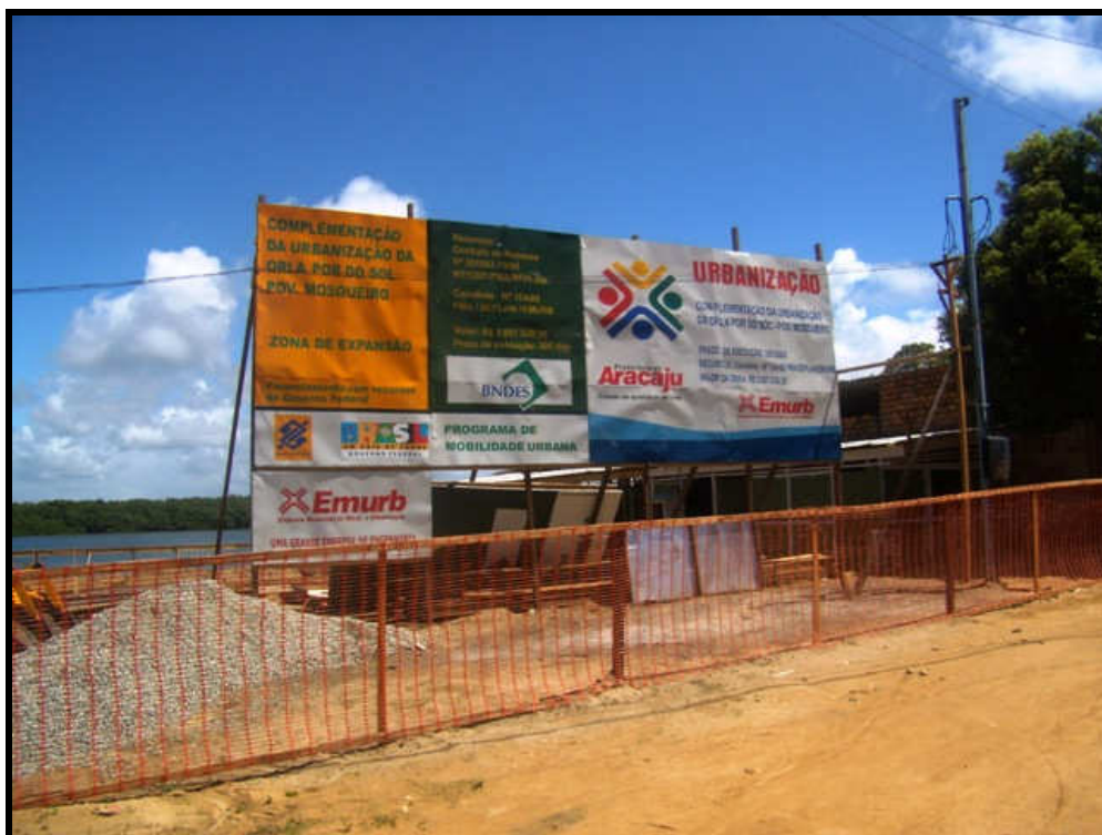
Figura 32: Infraestrutura na Orla Por do Sol, Povoado Mosqueiro. Foto: SANTANA FILHO, L. S, 2009.
