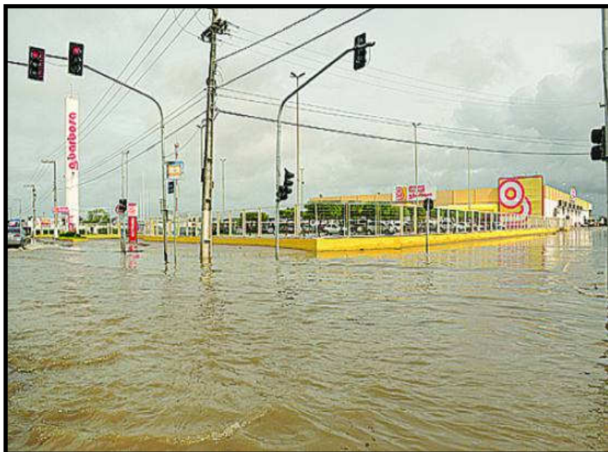
Figura 24: Problemas da macrodrenagem na zona de expansão de Aracaju.
