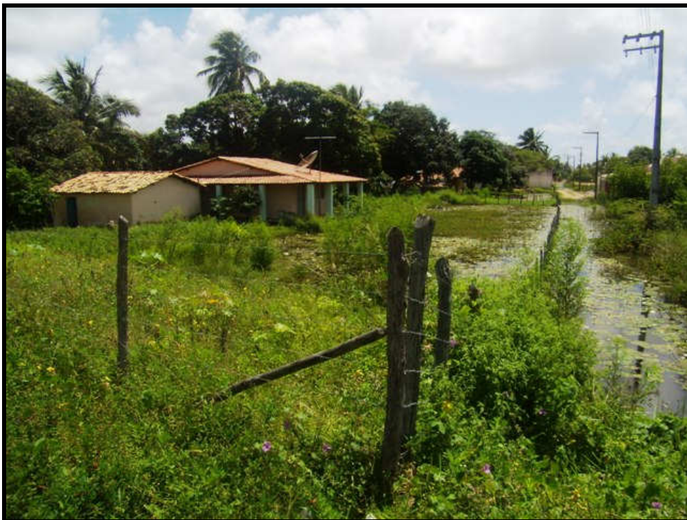
Figura 26: Afloramento de lençol freático junto a residência.
