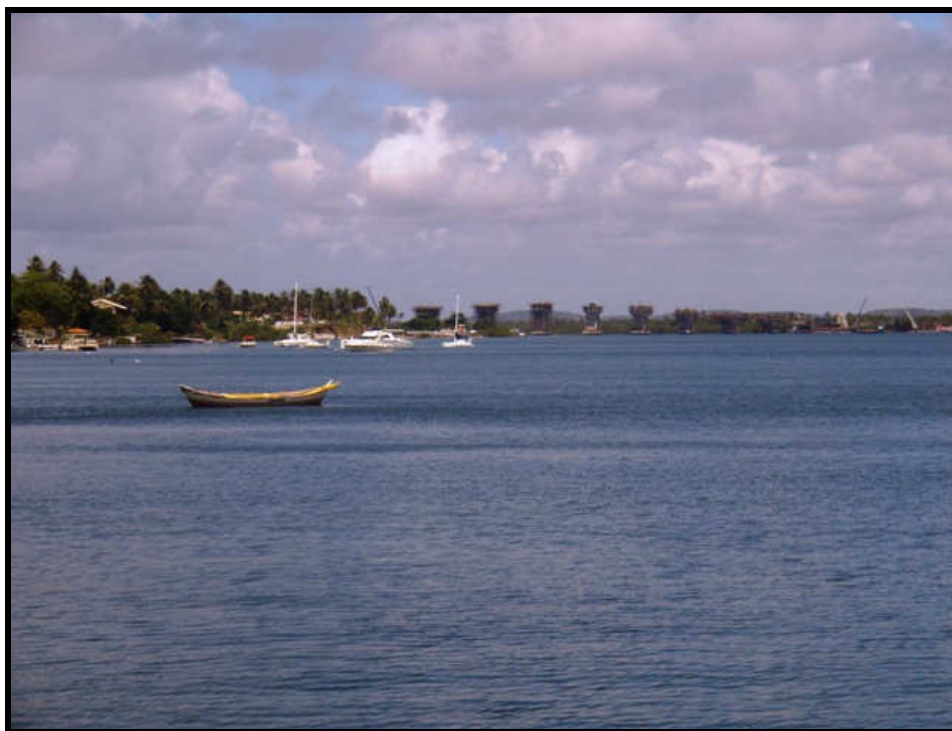
Figura 31: Ponte Jornalista Joel Silveira em construção sobre o rio Vaza Barris.
