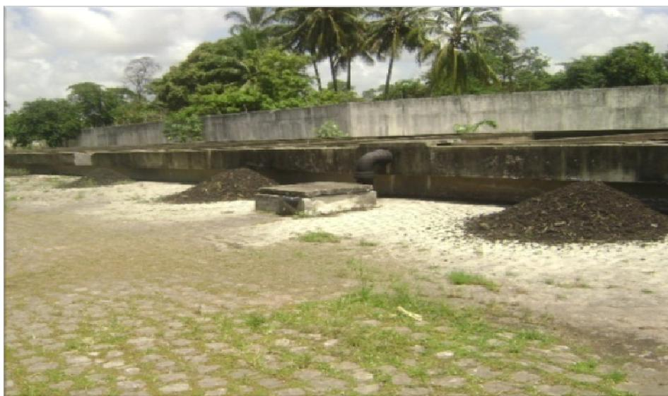
FIGURA 1. Leiras do lodo de esgoto seco. Estação de Tratamento de Esgoto do Bairro Orlando Dantas - DESO
