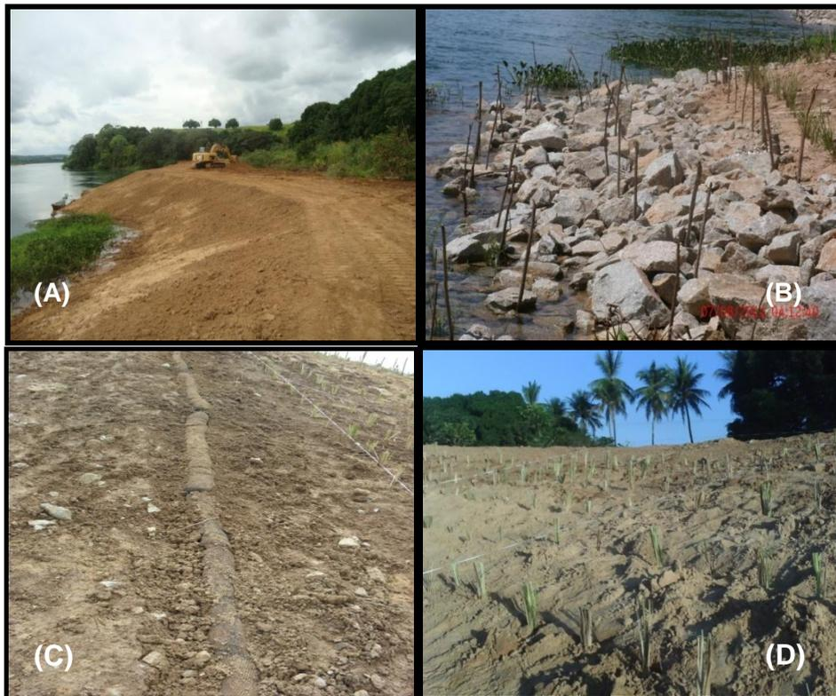
FIGURA 4. Ilustração das etapas de implantação da técnica de bioengenharia de solos : (A) Limpeza e retaludamento da área; (B) Enrocamento vegetado com estacas de sabiá; (C) Implantação de bermalongas; (D) Plantio Vetiver.
