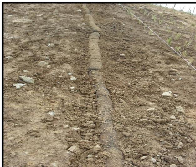
FIGURA 5. Retentores de sedimentos Bermalonga® D- 20 fixados na base do talude no Baixo São Francisco.
