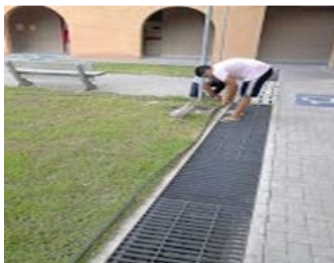
Figura 3 – Disposição das mangueiras e instalação das conexões.
