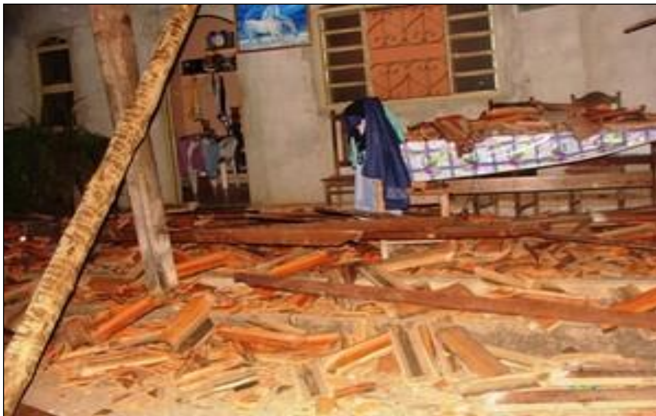
Figura 03: Foto de telhas caídas em decorrência do tremor de terra em 19/05/2012
