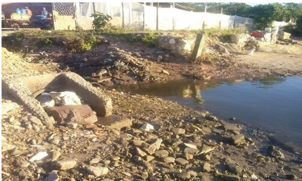
Figura 35 - Esgoto despejado no Rio do Sal, região do Porto Dantas
