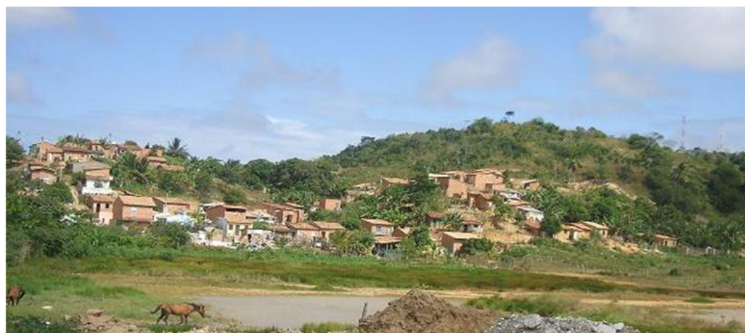
Figura 25 - Casas construídas ao redor da APA do Morro do Urubu
