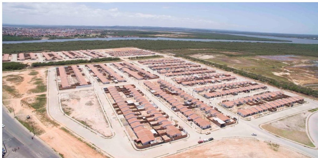
Figura 16 - Construção Conjunto Residencial Senador José Eduardo Dutra no Porto Dantas, com 580 unidades habitacionais
