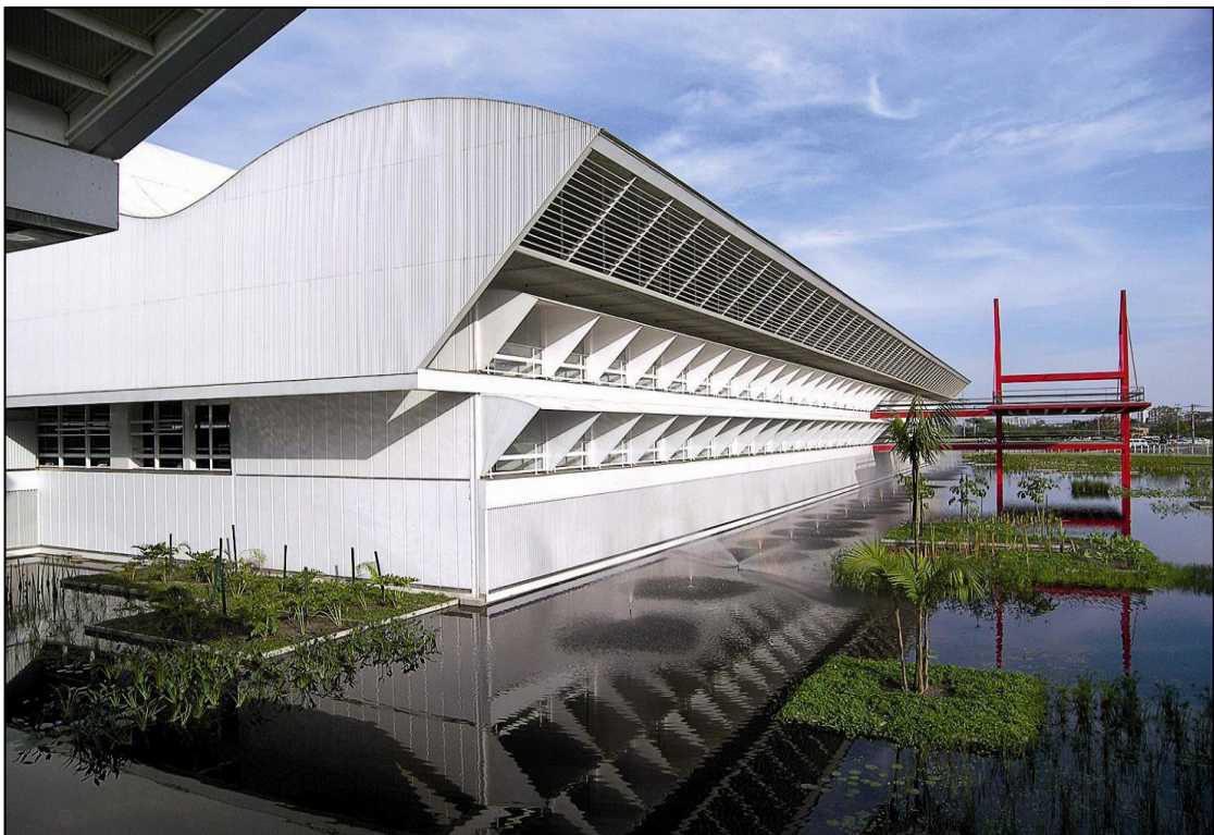
Figura 11 – Detalhe da Cobertura – Rede Sarah do Rio de Janeiro
