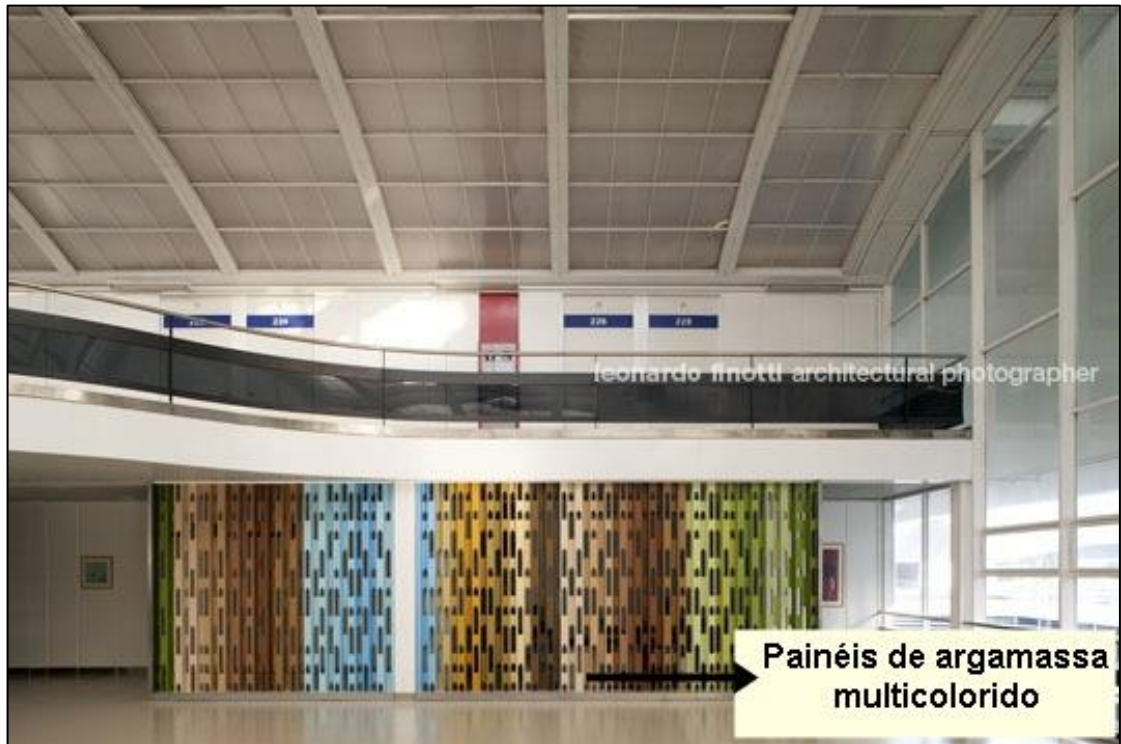
Figura 14 – Painéis de argamassa multicolorido – Rede Sarah do Rio de Janeiro
