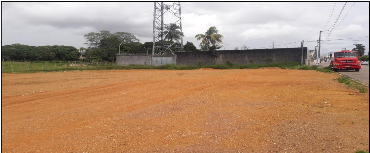
Figura 19 – Foto do Terreno – Ângulo 02
