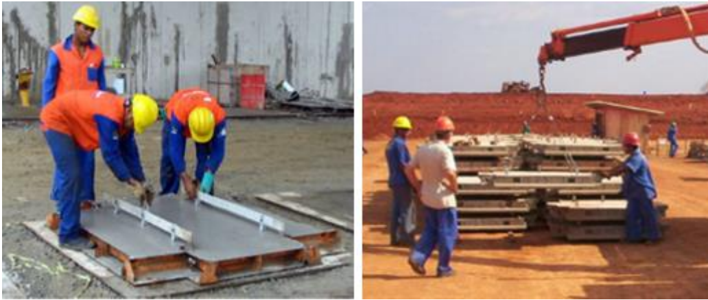
Figura 22 – Montagem e transporte dos painéis.
