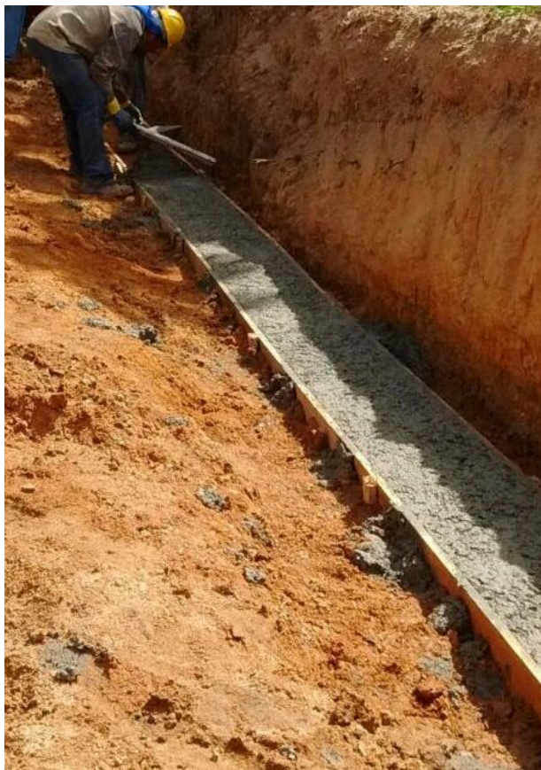
Figura 21 - Execução da soleira.
