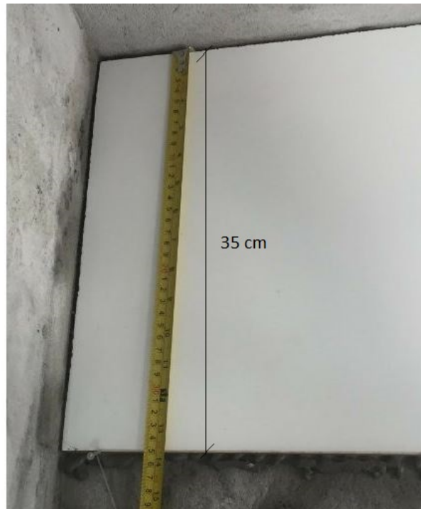
Figura 10 – Pré-condição inadequada - parte 1.
