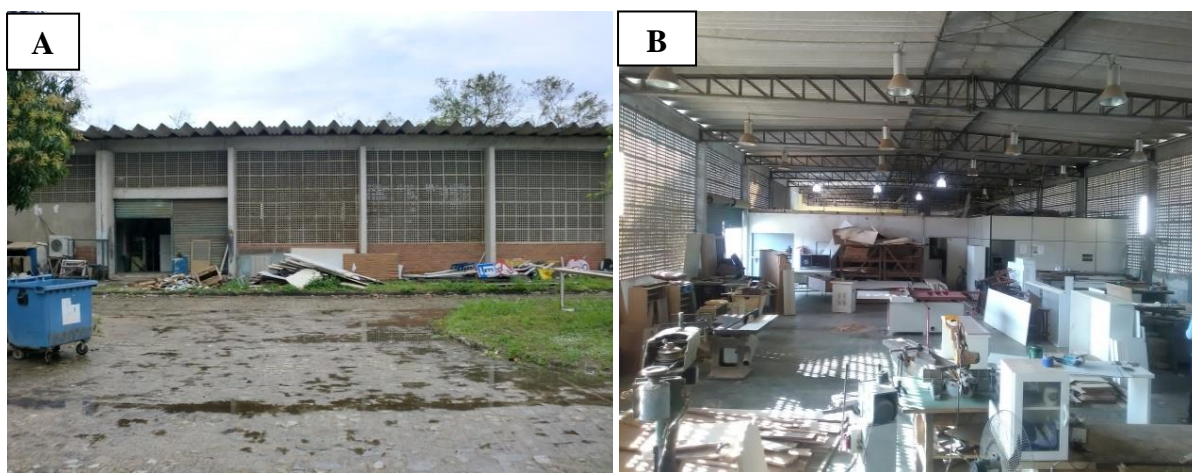
FIGURA 3 – aspectos gerais da marcenaria na UFS, 2017. A: visão externa da marcenaria; B: visão geral interna da marcenaria (Fonte: autoria.).
