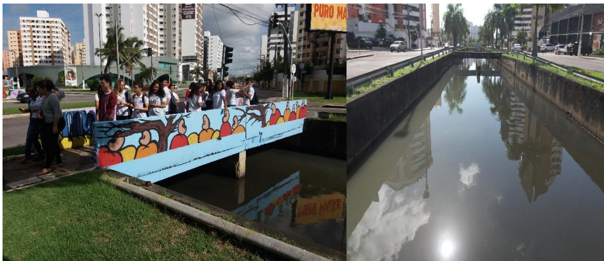
Figura 9 - Canal da avenida Pedro Valadares
