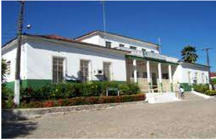
Figura 9 - Fachada do prédio central do IFS-Campus São Cristóvão
