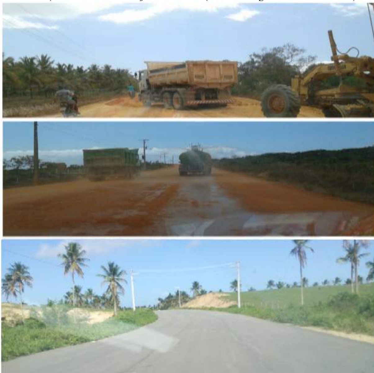
Figura 20 - Obras de Pavimentação da SE-100 Norte (acima e ao centro - fotografadas no ano de 2017) e Trecho da Rodovia já Pavimentado (abaixo - fotografado no ano de 2020).
