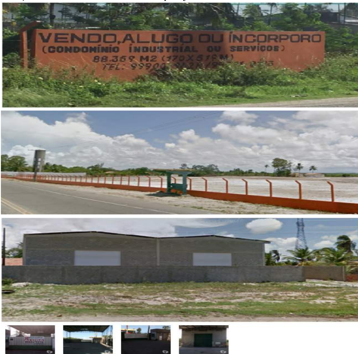
Figura 31 - Fachada Com Anúncio Visando a Construção de Condomínio Industrial ou de Serviços nas Proximidades do TMIB e Galpões já Construídos em Local Próximo.
