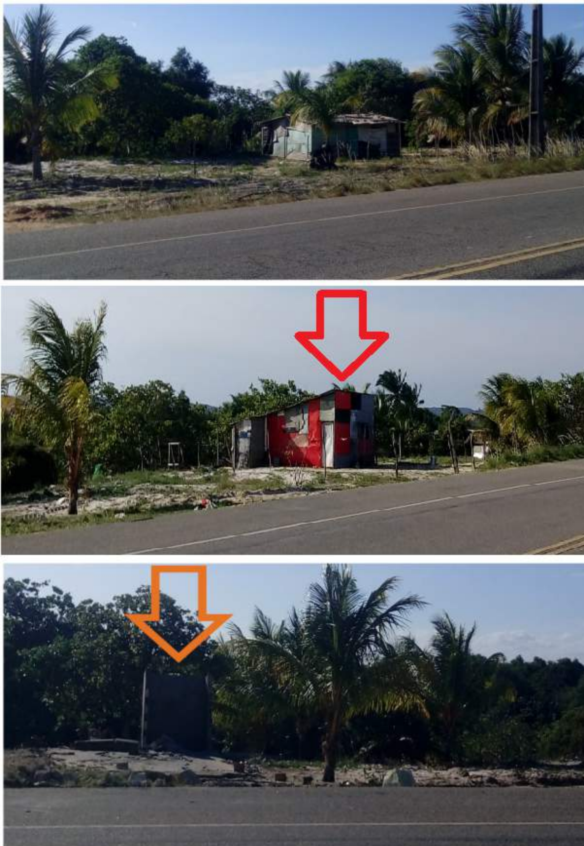
Figura 38 - Construções remanescentes e escombros (seta em laranja) identificados no local após a remoção da ocupação.
