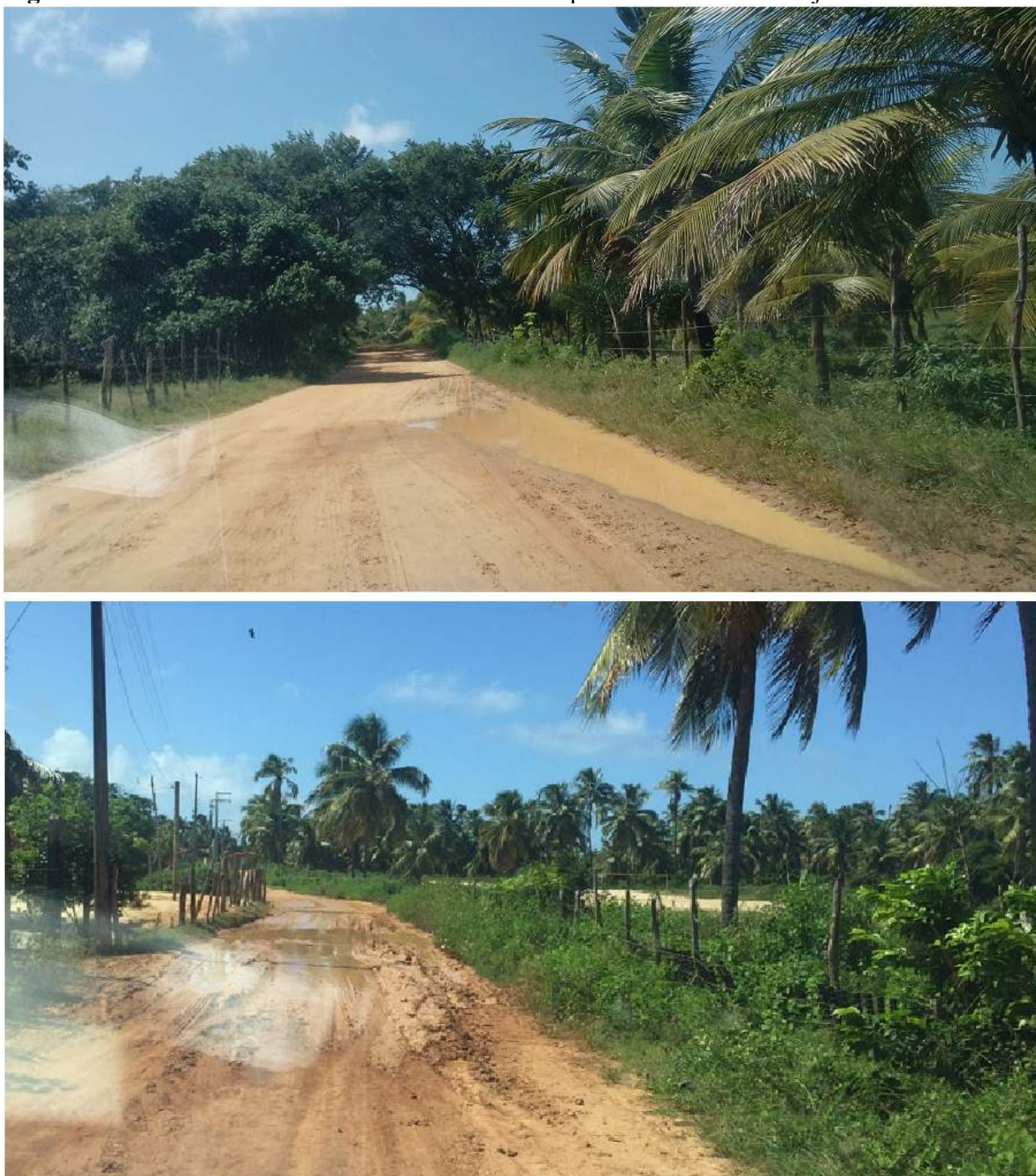
Figura 1 - Rodovia SE-100: Trecho Entre os Municípios de Pacatuba e Brejo Grande
