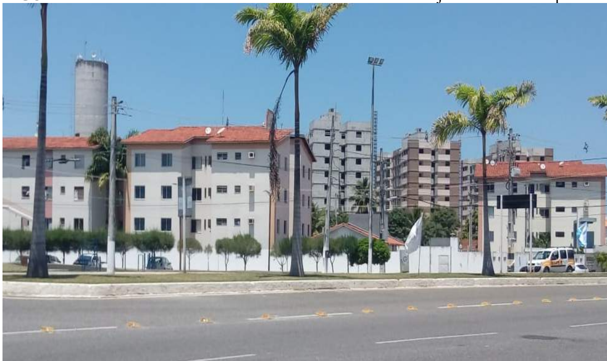
FIGURA 4 - Condomínios de Prédios na Cabeceira da Ponte Aracaju – Barra dos Coqueiros
