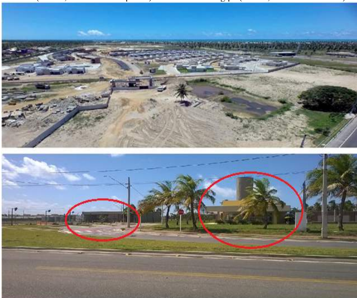
FIGURA 11 - Canteiro de Obras do Costa Paradiso (acima) e Pórticos de Entrada do Costa Paradiso (abaixo, destacado à esquerda) e do Damha I Sergipe (abaixo, destacado à direita).
