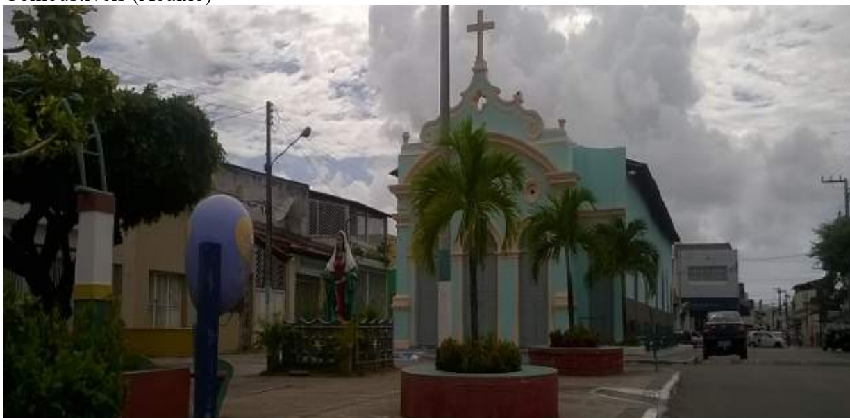
FIGURA 10 – Antigo Eixo Comercial de Barra dos Coqueiros: Praça de Santa Luzia (Acima), Ruínas do Antigo Terminal Hidroviário (Ao Centro) e Ruínas do Antigo Posto de Combustíveis (Abaixo)
