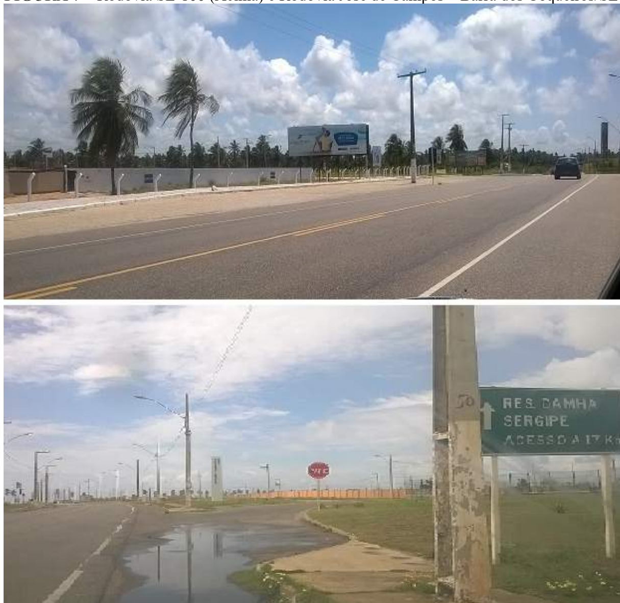
FIGURA 7 – Rodovia SE-100 (Acima) e Rodovia José de Campos – Barra dos Coqueiros/SE
