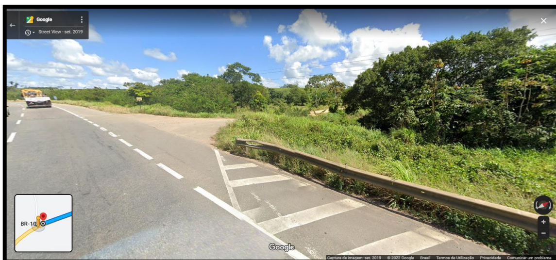
Ponte sobre o Riacho Pindoba, no quilômetro 109 Sul da BR 101, e acesso a estrada oitocentista que leva ao Sítio Aldeia Velha, em São Cristóvão/Sergipe (acesso do Google Maps, em maio de 2022).
