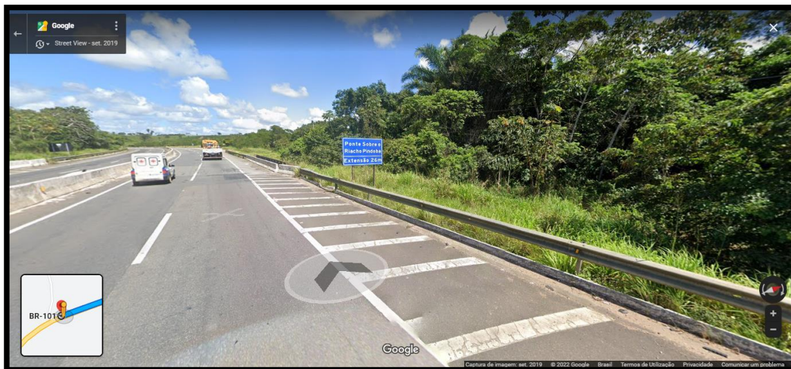
Vista da ponte sobre o Riacho Pindoba, no quilômetro 109 Sul da BR 101, via Google Maps (acesso em maio de 2022).
