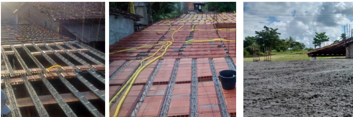
Figura 73 – Execução da laje
