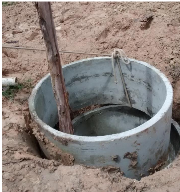
Figura 77 – Execução da fossa
