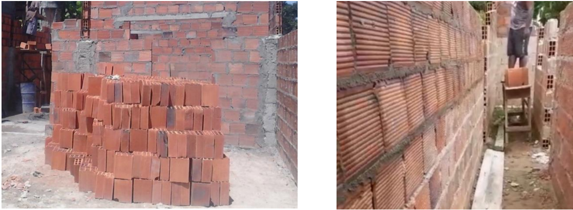
Figura 68 – Execução da alvenaria
