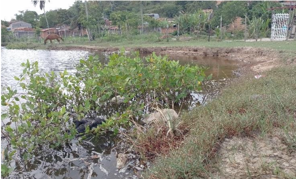
FIGURA 47 – Registro de assoreamento e sacos de lixo doméstico próximo ao campo, à margem do rio.
