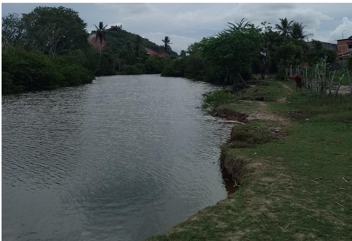
FIGURA 49 – Registro do assoreamento do rio e ao fundo, ao centro da imagem, morro da Igreja Bom Jesus dos Navegantes.
