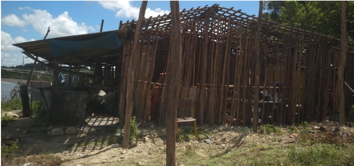
FIGURA 53 – Estrutura de um barraco que está em reforma.
