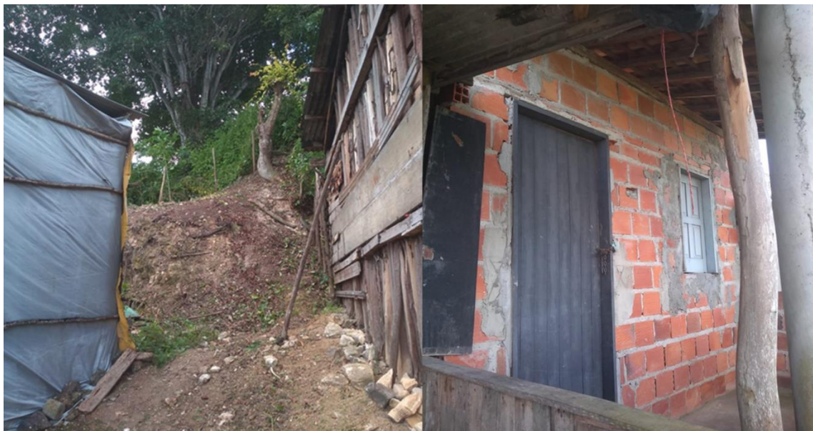
FIGURA 54 – Exemplos de vedação de alguns barracos da Vila.
