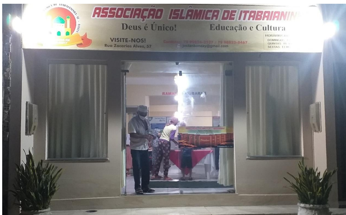
Figura 8: Fachada da Associação Islâmica de Itabaianinha
