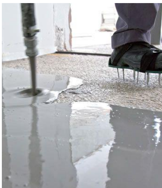
Figura 10 - Utilização de sapatilha de pregos na aplicação da argamassa autonivelante
