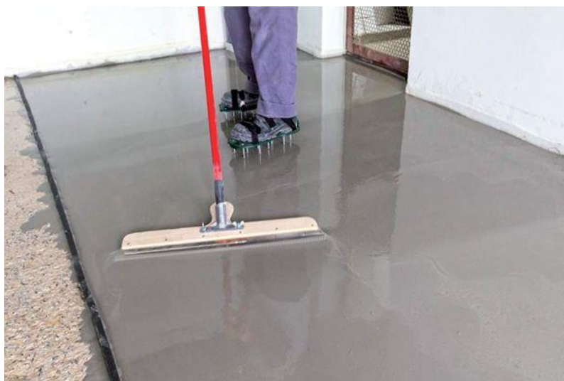
Figura 11 - Acabamento do contrapiso autonivelante
