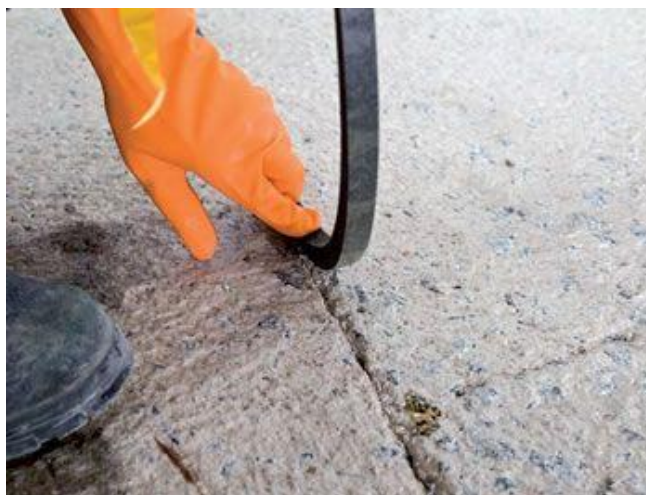
Figura 6 - Demarcação das juntas de dilatação
