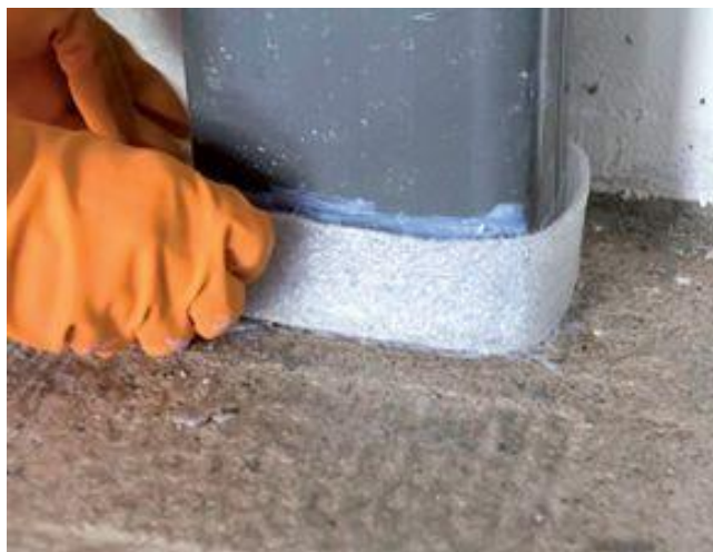
Figura 7 - Colocação da fita de poliestireno expandido
