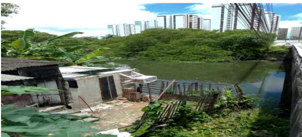
Figura 5.9 - Imagem de edificações com despejo de esgoto no rio Poxim no conjunto Santa Lúcia. Fonte: Pesquisa direta do autor (2022)
