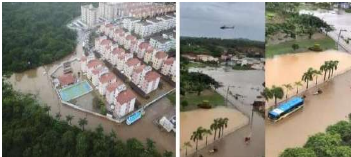
Figura 4.13 - Imagens da inundação no Conjunto Santa Lúcia no bairro Jabotiana. Fonte: COMPDEC (2020) 57 .
