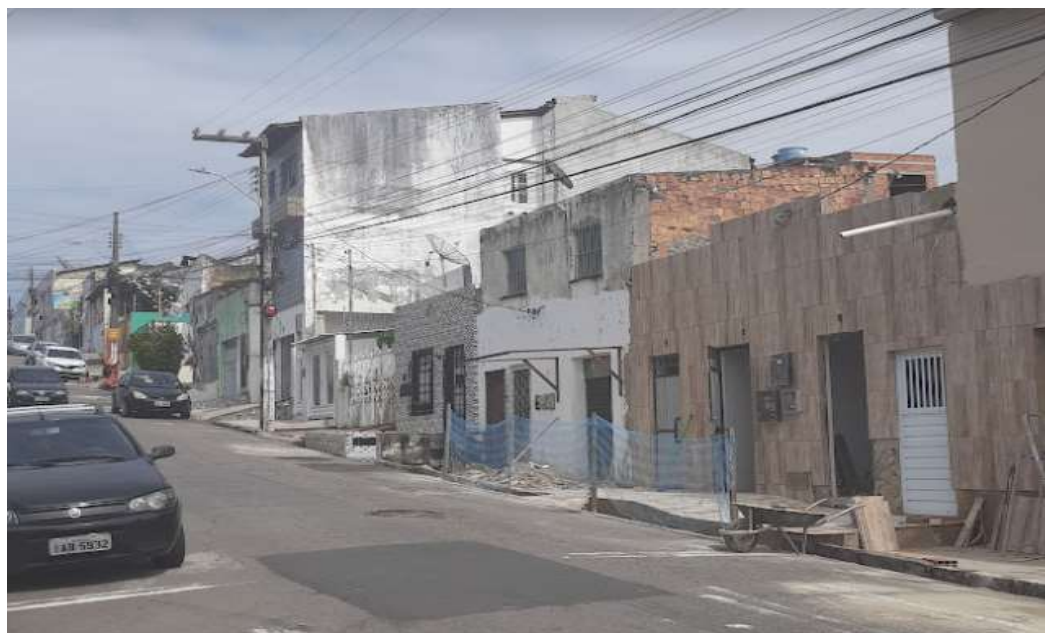
Figura 30- Trecho da Rua Siriri onde se instalava o Curral do Bomfim na atualidade.
