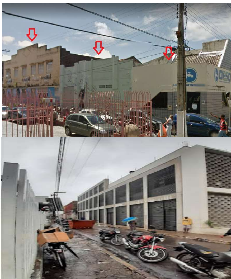
Figura 20 - Indicação das edificações que foram demolidas no Beco dos Cocos (2017) e o prédio do SESC que tomou seu lugar (2022). 30
