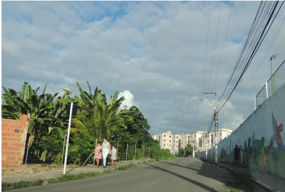
Figura 5: Rua sem esgoto a céu aberto
