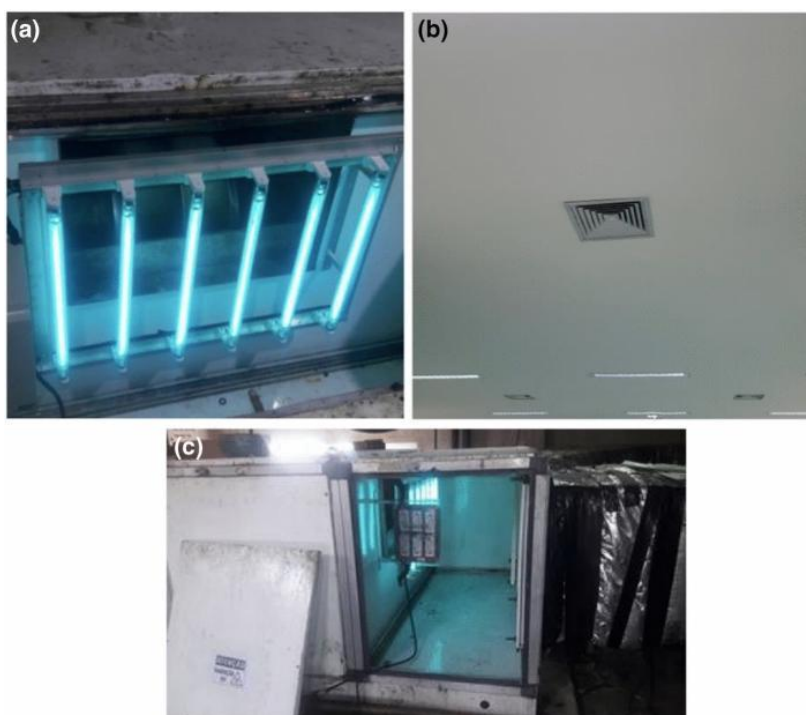
Figura 23 - Imagem real da instalação do equipamento de desinfecção desenvolvido no instalado em um AVAC no Hospital Universitário de Lagarto.
