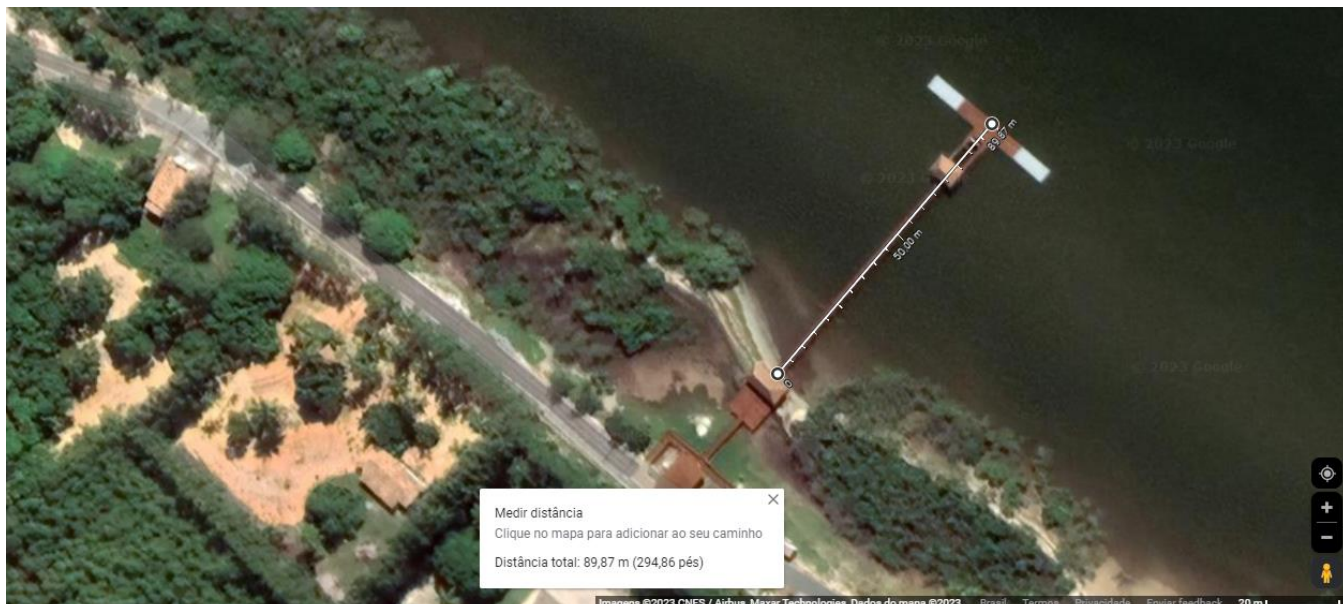
Figura 18: Píer construído no VIDAM Náutico Clube & Praias. Fonte: Google Maps.
