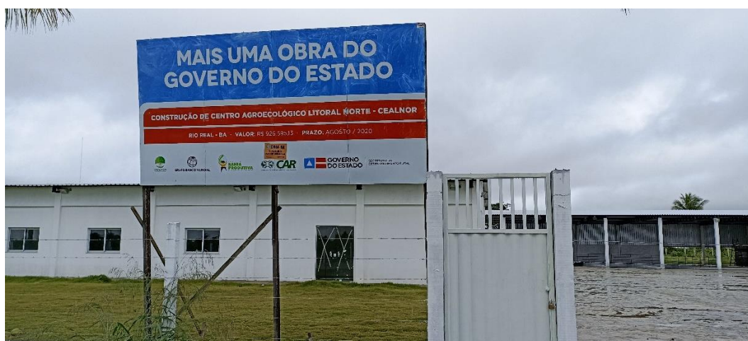
Figura 13 – Nova sede da CEALNOR em construção (Rio Real/BA)
