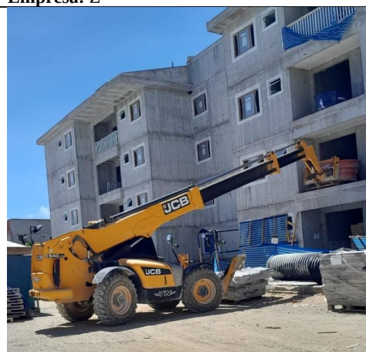
Descrição: Utilização de transporte vertical Categoria de AF: Preparação do trabalho Empresa: Y
