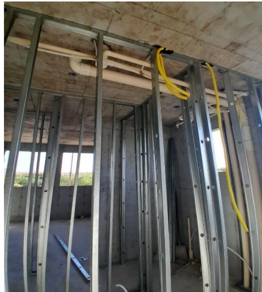
Figura 18. Preparação para instalações hidrossanitárias
