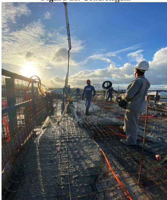
Figura 21. Concretagem
