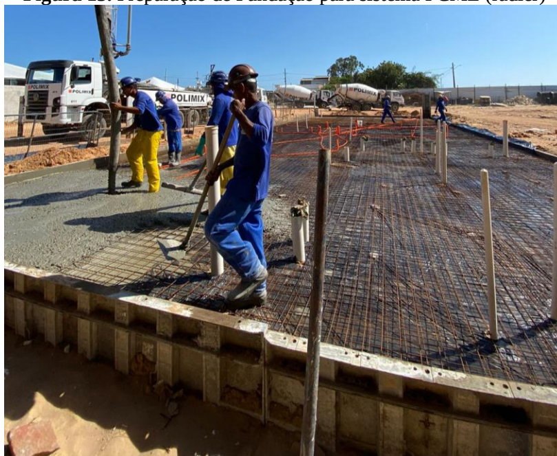
Figura 15. Preparação de Fundação para sistema PCML (radier)
