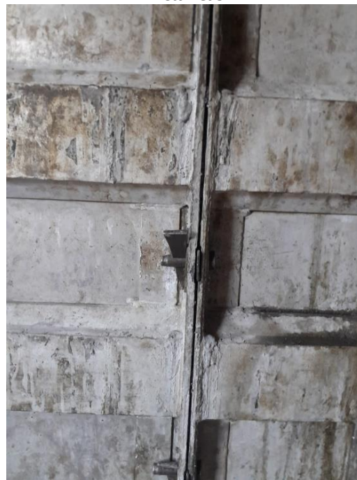
Figura 20. Travamento das fôrmas metálicas
