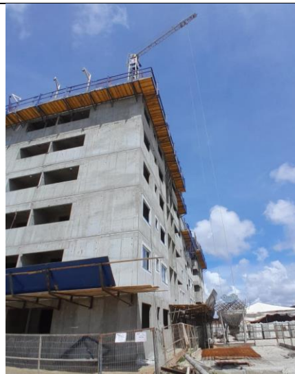
Descrição: Utilização de grua para transporte de material Categoria de AF: Preparação do trabalho Empresa: Z
