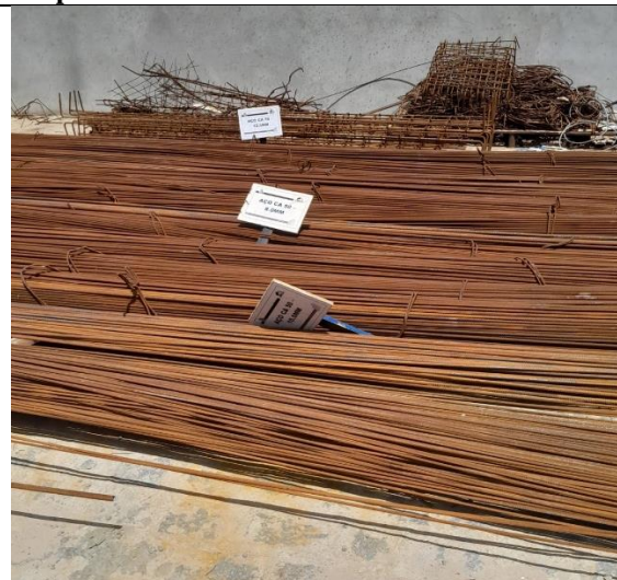
Descrição: Identificação de barras de aço Categoria de AF: Preparação do trabalho Empresa: Z
