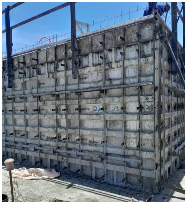
Figura 19. Fôrma para parede de concreto do tipo metálica
