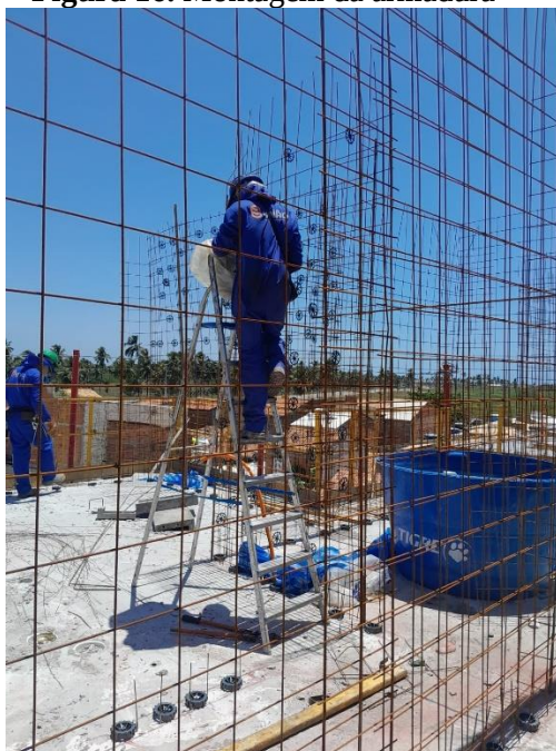
Figura 16. Montagem da armadura
