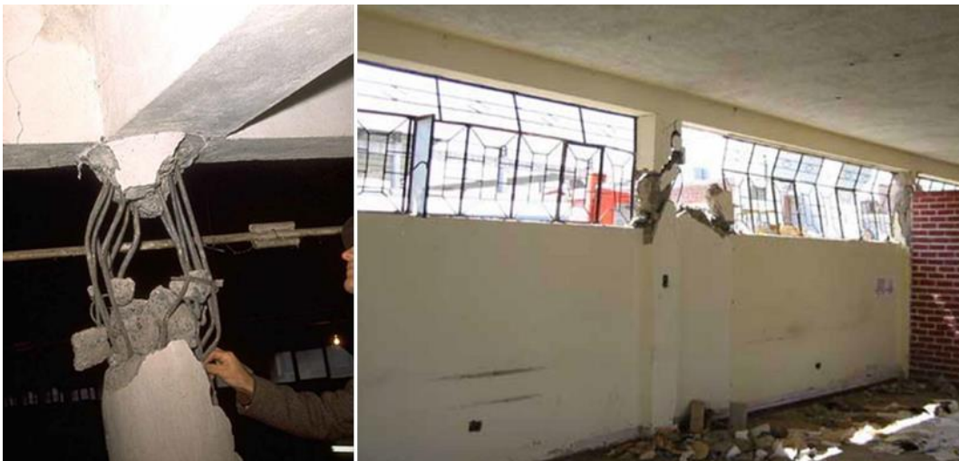
Figura 3.1 – Efeitos inelásticos em estruturas de concreto armado
