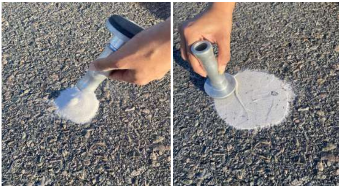
Figura 28 – Aplicação e espalhamento da areia no pavimento
