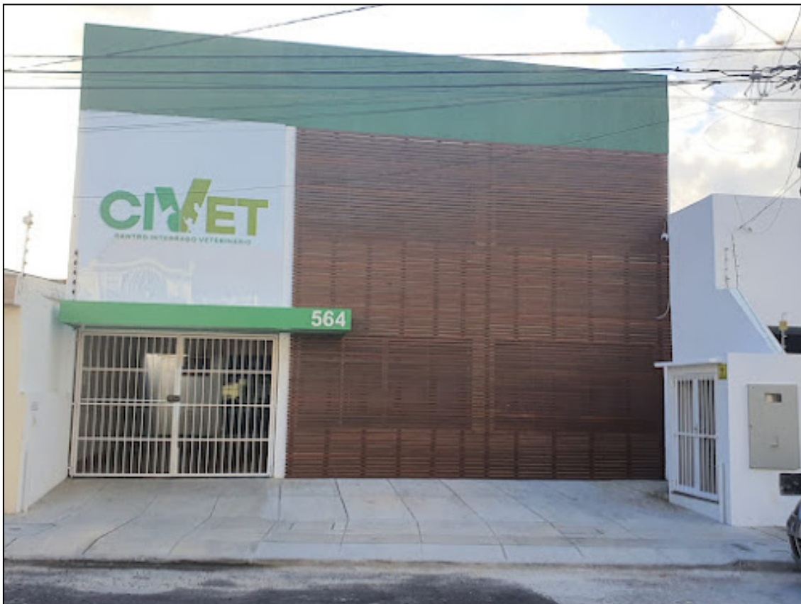
Figura 1: Fachada do CIVET. Fonte: Arquivo pessoal (2024).
