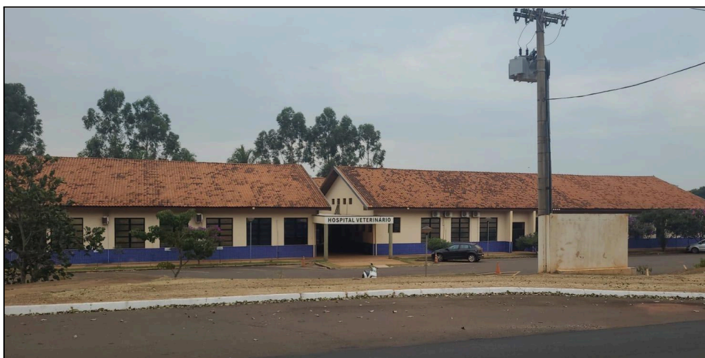
Figura 21: Vista frontal da entrada do HOVET/FZEA. Fonte: Arquivo pessoal (2024).
