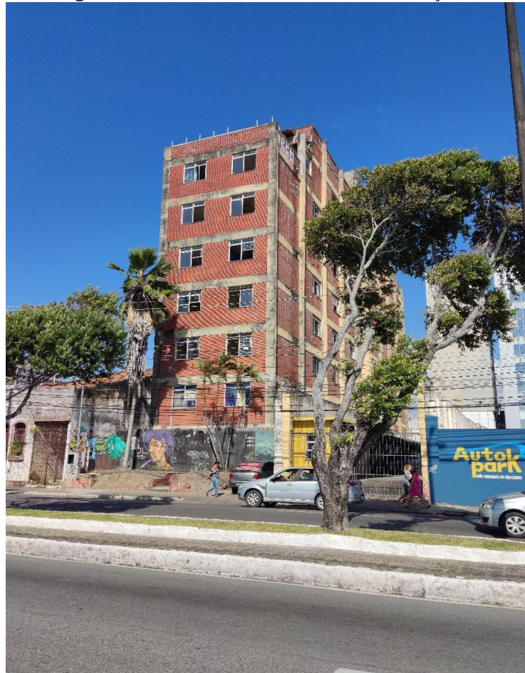
Figura 6: Edifício Bela Vista no Centro de Aracaju/SE
