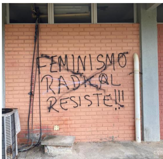
Figura 1 - pixação no muro externo do CCET da UFS
