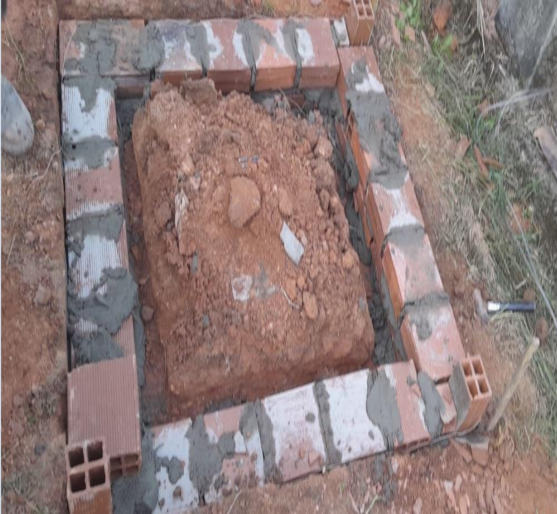
Figura 07 – Construção da base
