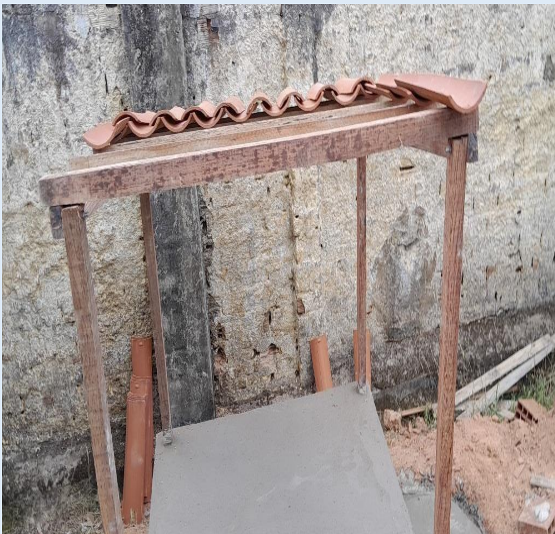
Figura 09 – Montagem do telhado na base
