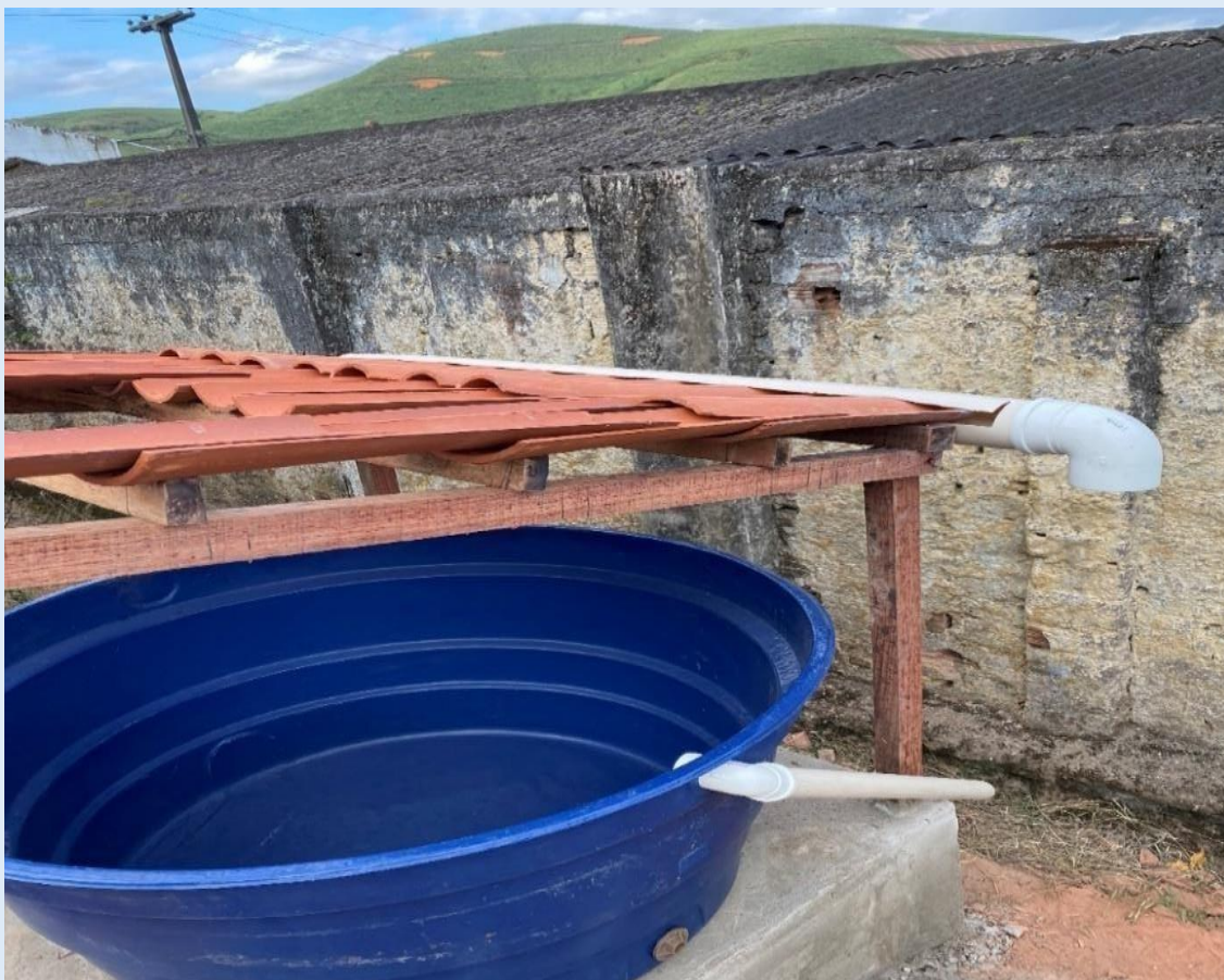
Figura 10 – Fixação da Caixa d'água
