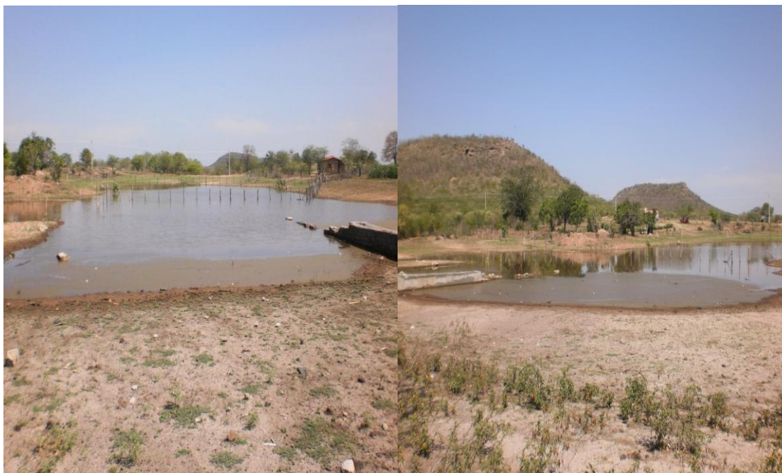
Foto 40: Reservatório após precipitação, UC Lagoa do Frio.
