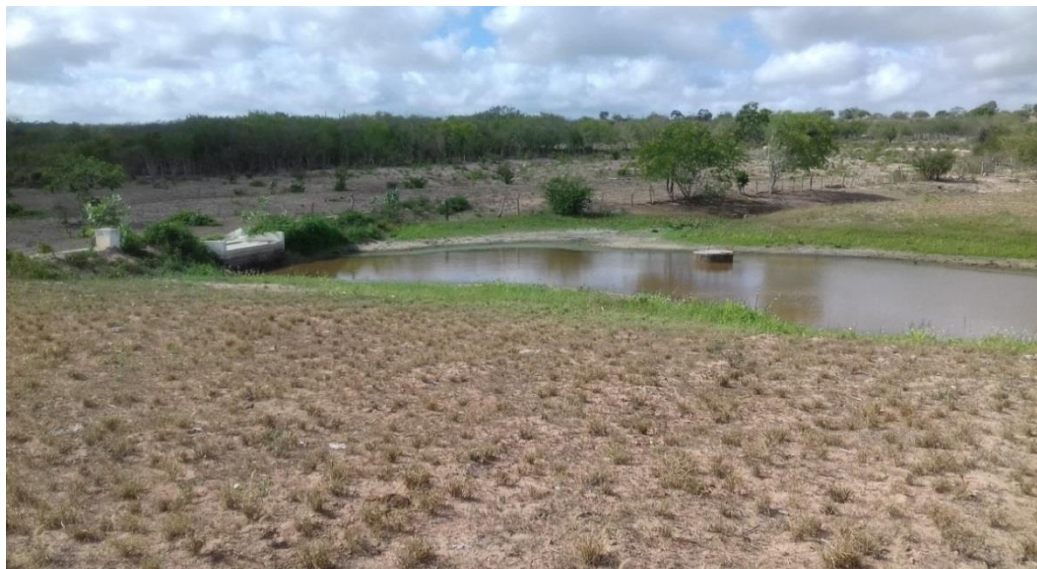
Figura 61-Representação de uma barragem subterrânea em Linda Flor Porto da Folha Estado de Sergipe
