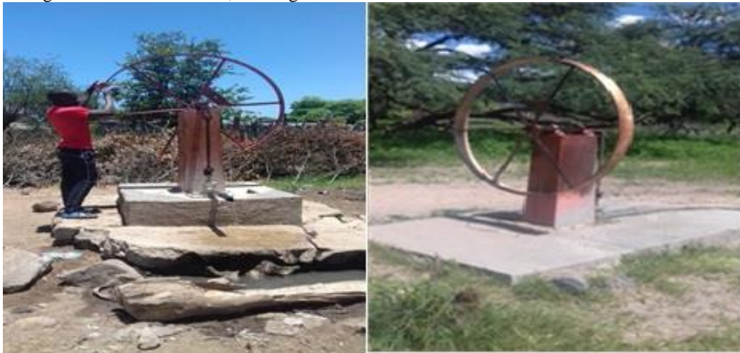
Figura 50- Representação de furos de captação de água subterrânea (operacional e obsoleta) na bacia hidrográfica do rio Caculuar, em Angola
