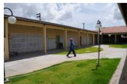
Mais três escolas vão ser construídas no bairro 17 de Março e comunidade Coqueiral
