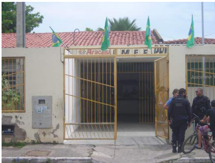
Figura 9 – Fotografia da fachada da EMEF Pres. Juscelino Kubitschek
