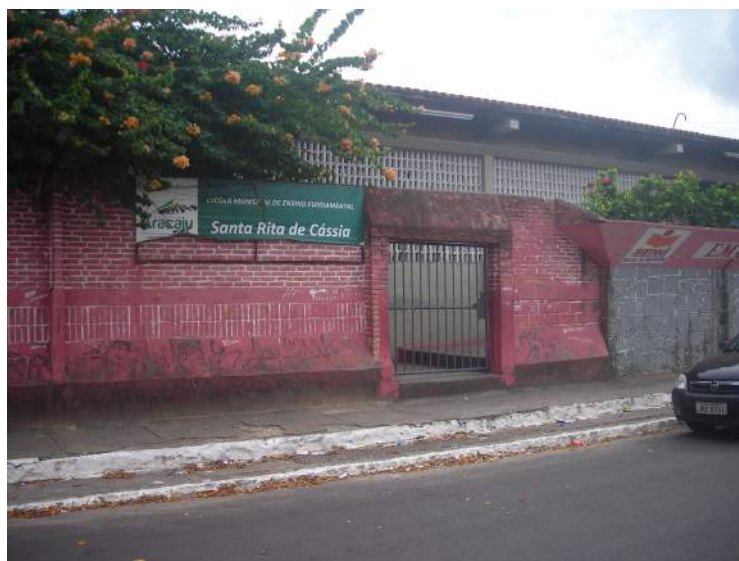
Figura 13 – Fotografia da fachada da EMEF Santa Rita de Cássia
