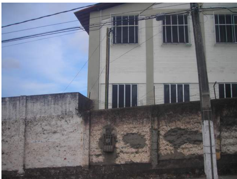
Figura 24 – Infraestrutura da entrada de energia da EMEF Santa Rita de Cássia
