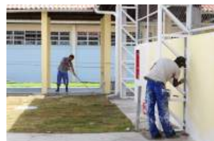
Obras estão sendo executadas em quatro unidades de ensino
