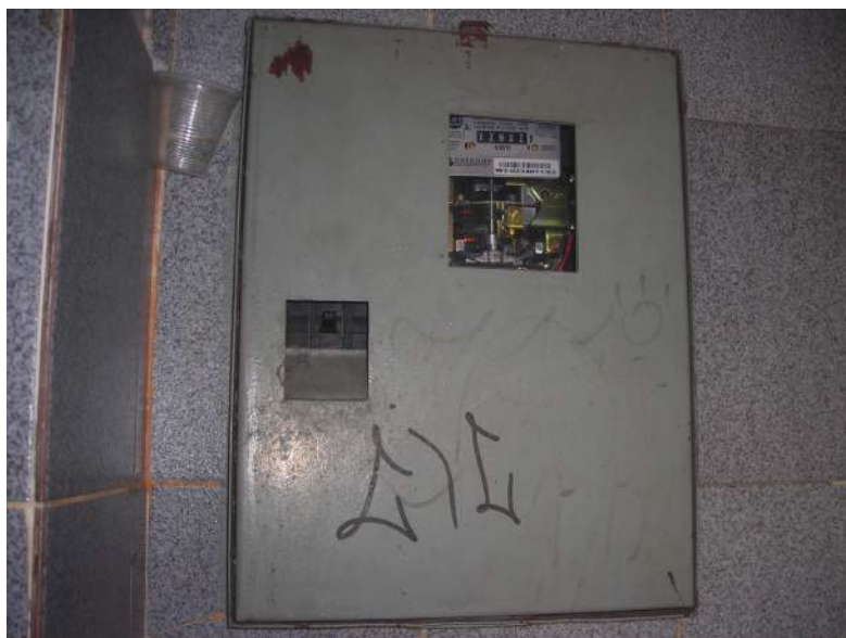
Figura 25 – Quadro de entrada de energia do prédio 1 da EMEF Santa Rita de Cássia
