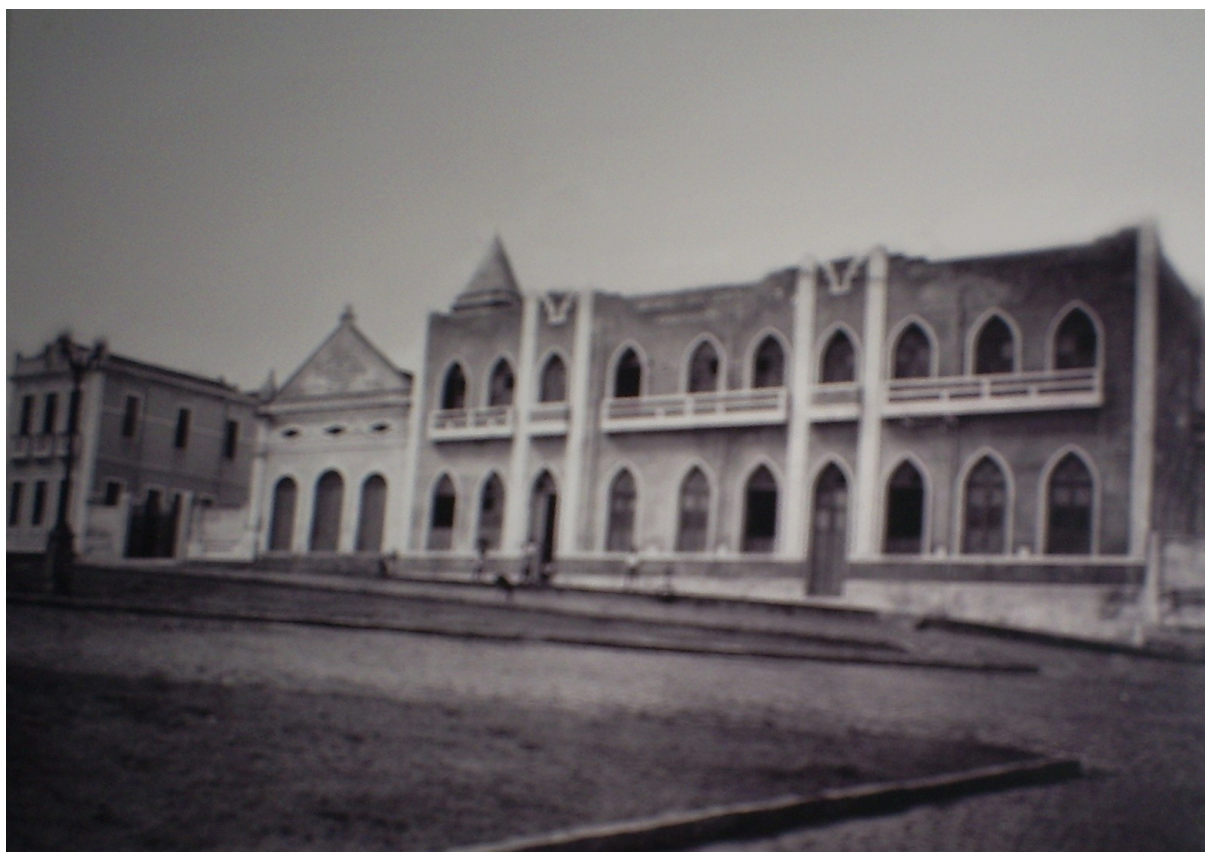
FOTO 19: Fachada do Colégio Nossa Senhora das Graças. 1954. FONTE: Acervo do Colégio Nossa Senhora das Graças. AUTORIA: Desconhecida
