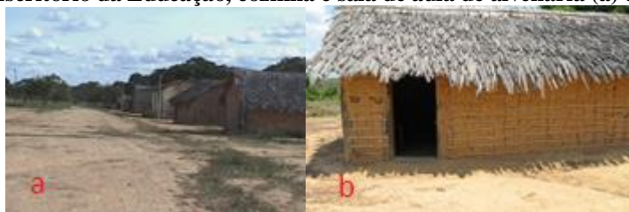
Figura 9 - Escritório da Educação, cozinha e sala de aula de alvenaria (a) e cozinha (b).
