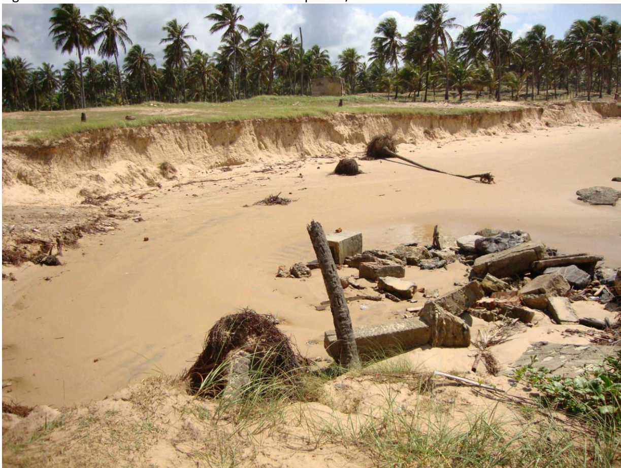
Figura 58 – Comunidade halófila em Barra dos Coqueiros/SE.
