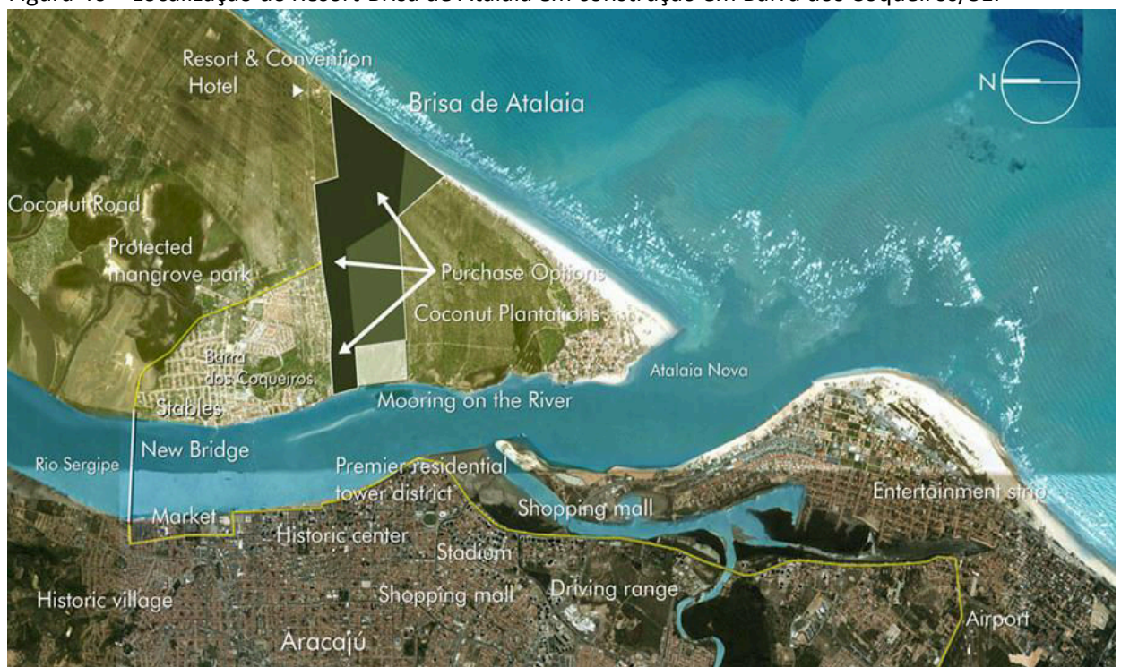
Figura 46 – Localização do Resort Brisa de Atalaia em construção em Barra dos Coqueiros/SE.
