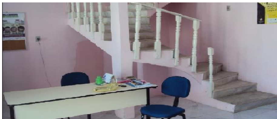
Figura 7: Escada que dá acesso ao pavimento superior do prédio
