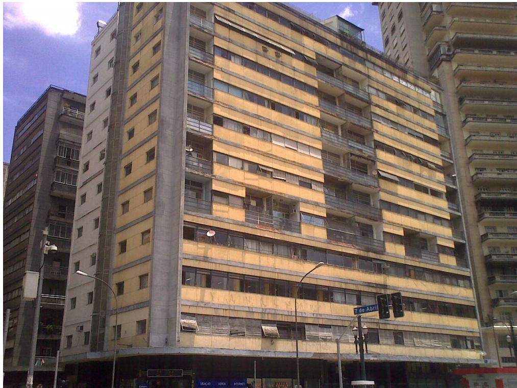
Figura 10: Fachada do Edifício Esther, voltado para a Avenida Ipiranga.
