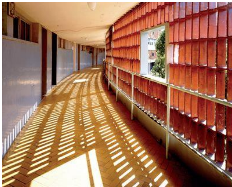
Figura 4: Corredor de acesso aos apartamentos do edifício principal do Conjunto Pedregulho.
