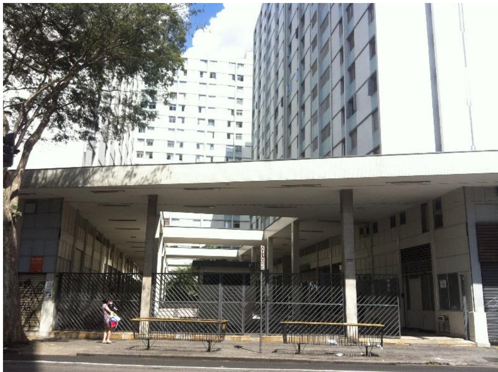
Figura 7: Condomínio Nova Perimetral, Av. Brigadeiro Luís Antônio.
