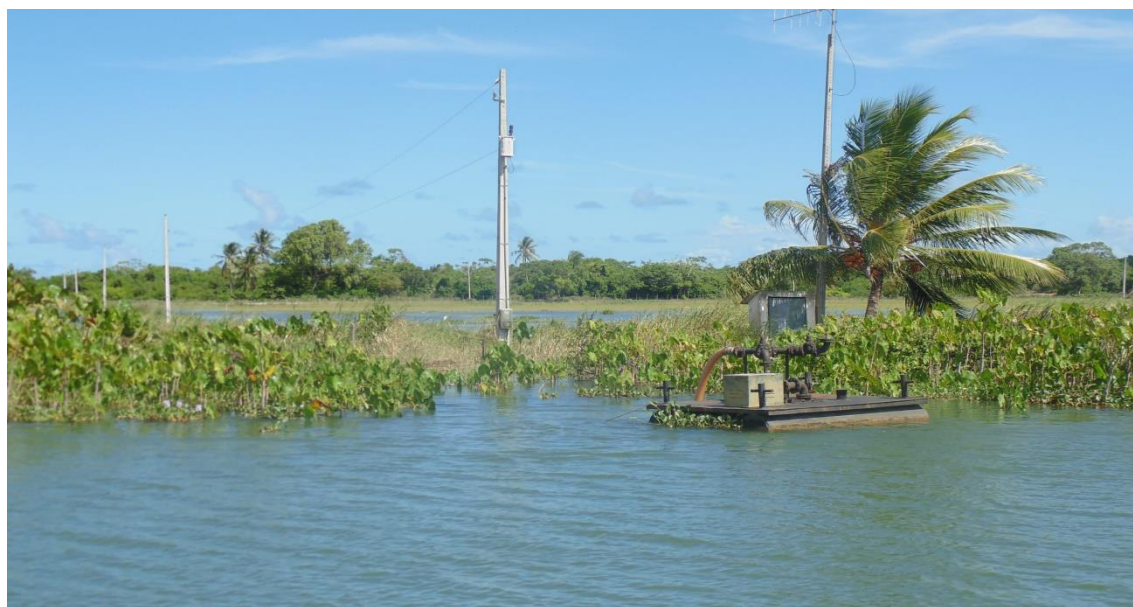
Figura 2: Bomba de captação de água para consumo operada pela companhia estadual de saneamento do estado de Sergipe, localizada em Brejo Grande/SE.
